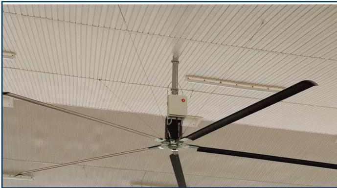
Le système de ventilation Serco HVLS fournit un refroidissement rapide de haute qualité pour tous les types de bétail. Le fonctionnement à vitesse variable permet au système de s'ajuster en fonction des conditions de température actuelles dans votre étable. De plus, la fonction de fonctionnement inversé souffle de l'air vers le haut, ce qui mélange la chaleur en couches dans l'étable par temps froid.
